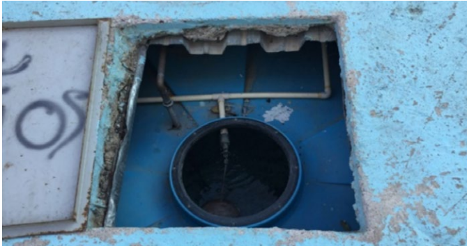
Imagen 7 Cisterna del comedor
