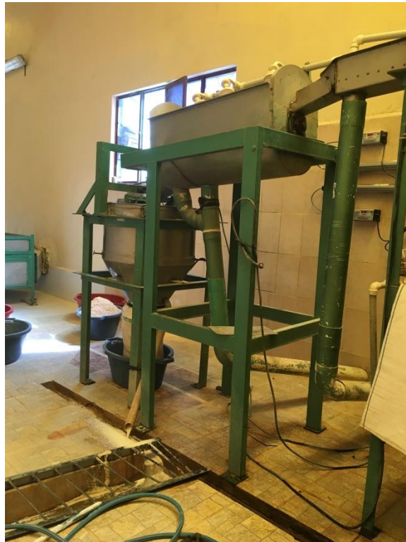
Etapa de lavado a presión
