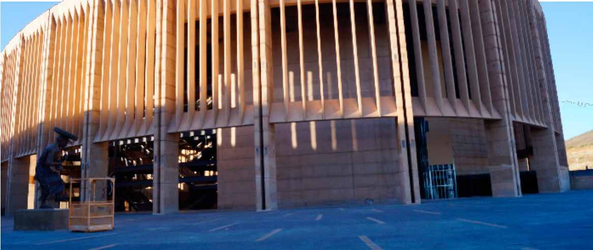
Centro Cultural Centenario Toma de Zacatecas, inaugurado al final del sexenio de Miguel Alonso Reyes, cuya obra quedó inconclusa a pesar de la voluminosa inversión en cerca de mil millones de pesos.
