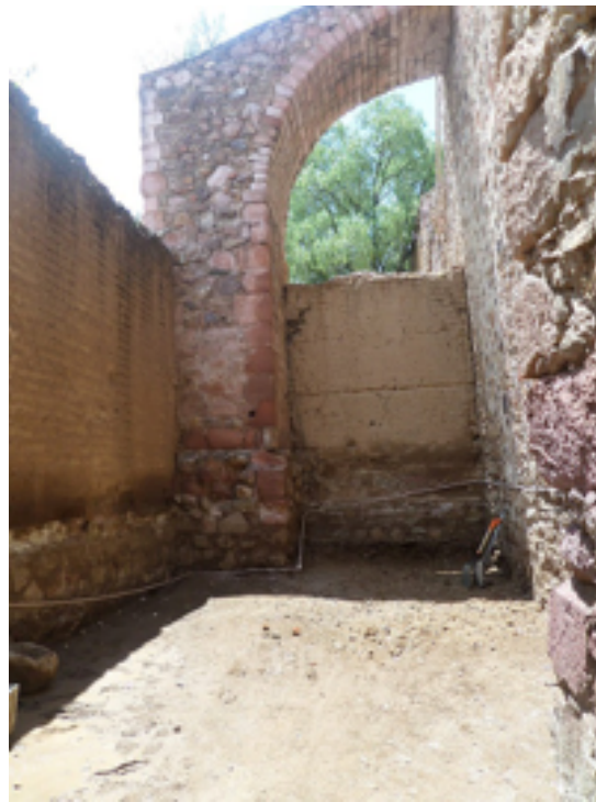
Imagen 9 Vista general del «patio» con identificación de piso de tierra
