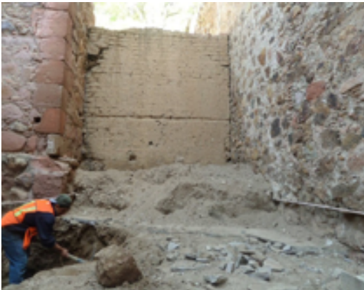
Imagen 8 Intervención en el patio 2
