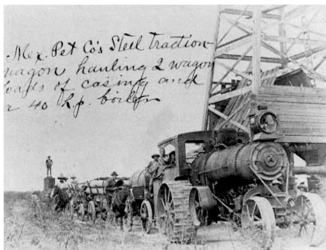
1902: Arrastrando revestimiento para pozos y una caldera en San Luis Potosí para la Mexican Petroleum Company of California, propiedad de Edward Doheny y C.A. Canfield (con torre de perforación hecho de madera al fondo).
